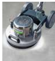
▶ Aufarbeiten und Schleifen von Estrichböden
